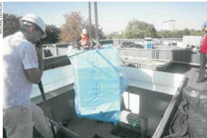
Cyklotron trafił na miejsce dzięki specjalistycznemu dźwigowi
